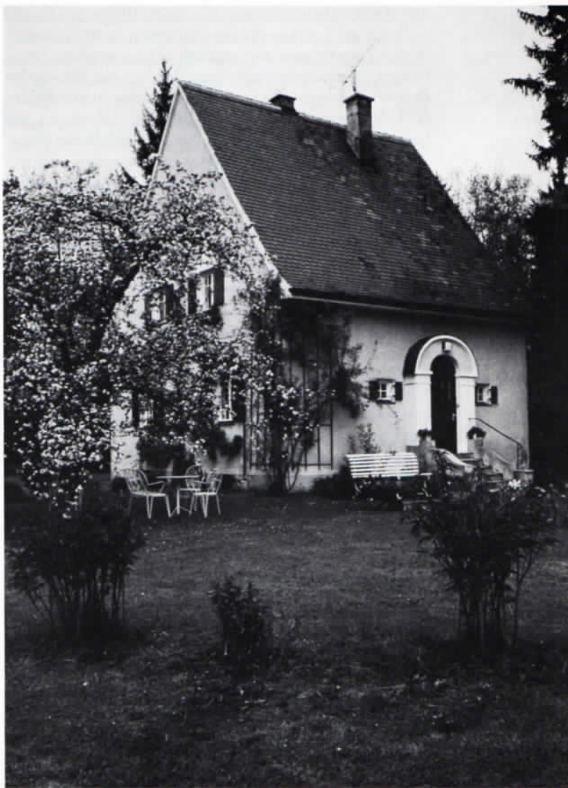
Das »Thiemann-Haus« in Dachau, Hermann-Stockmann-Straße 20.
