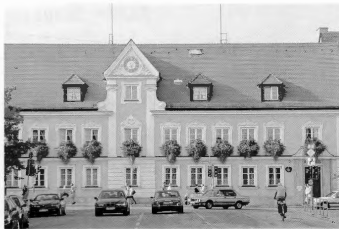
»Neues Rathaus«, im 16. Jh. in Besitz des Klostersrichters (»Zwerchhaus«), 1688 von einer Brauerei und 1834 von der Marktgemeinde Bruck erworben, dann an den Staat als Landgerichtsgebäude vermietet. Seit 1973 Rathaus. Die neubarocke Stuckdekorfassade stammt von 1914.
