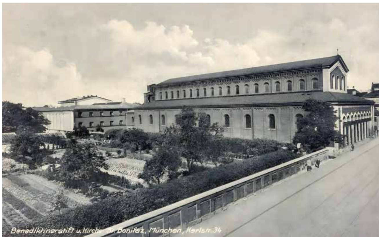
Abb. 1: Die Benediktinerabtei St. Bonifaz in München vor der Zerstörung im Zweiten Weltkrieg, Archiv der Benediktinerabtei St. Bonifaz (AAB), Bildsammlung, B 651.
