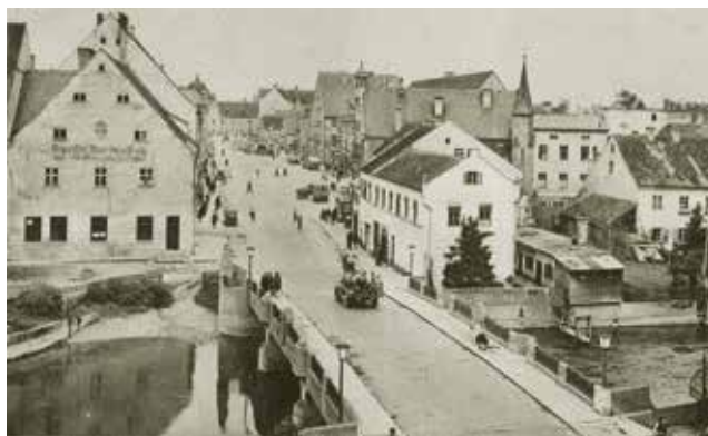
Abb. 8: Amperbrücke in Fürstenfeldbruck um 1946.
