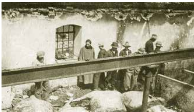
Abb. 4: Bei Luftangriff zerstörter Bauernhof von Bürgermeister Eberl in Hattenhofen.
