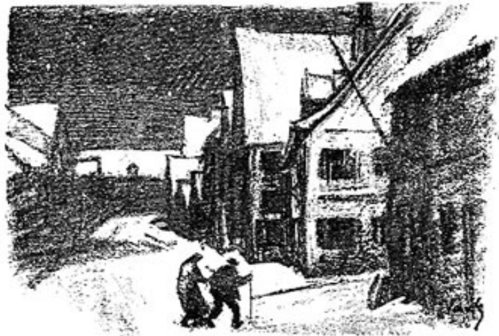
Im Markt Bruck: Schrankenhaus (1934 abgebrochen), Storchwirt, der alte Bichlerbräu, die hohen Giebel zum Zwerchhaus hinauf.
