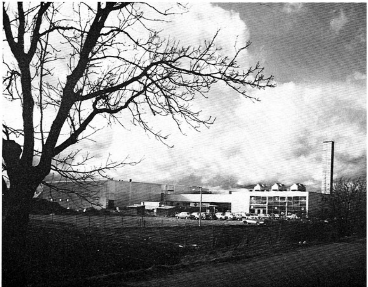
Die neue Anlage der Fleischwarenfabrik Schweißfurt in Dachau-Ost.
