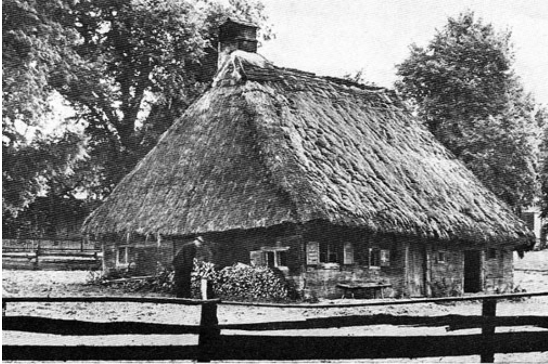
Söldenhäusl in Bergham bei Erding
