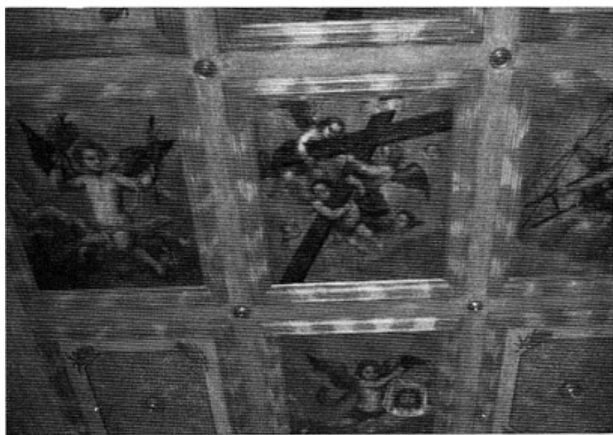
Die durch Freilegung entdeckte, nunmehr restaurierte Kassetten- decke in der Kirche von Zellhof bei Schöngesing.
