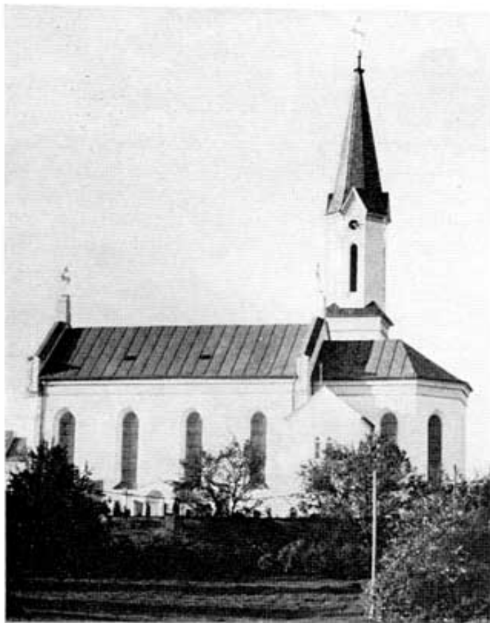
Abb. 1: Südansicht der vor 110 Jahren erbauten Pfarrkirche von Wolfersdorf.
