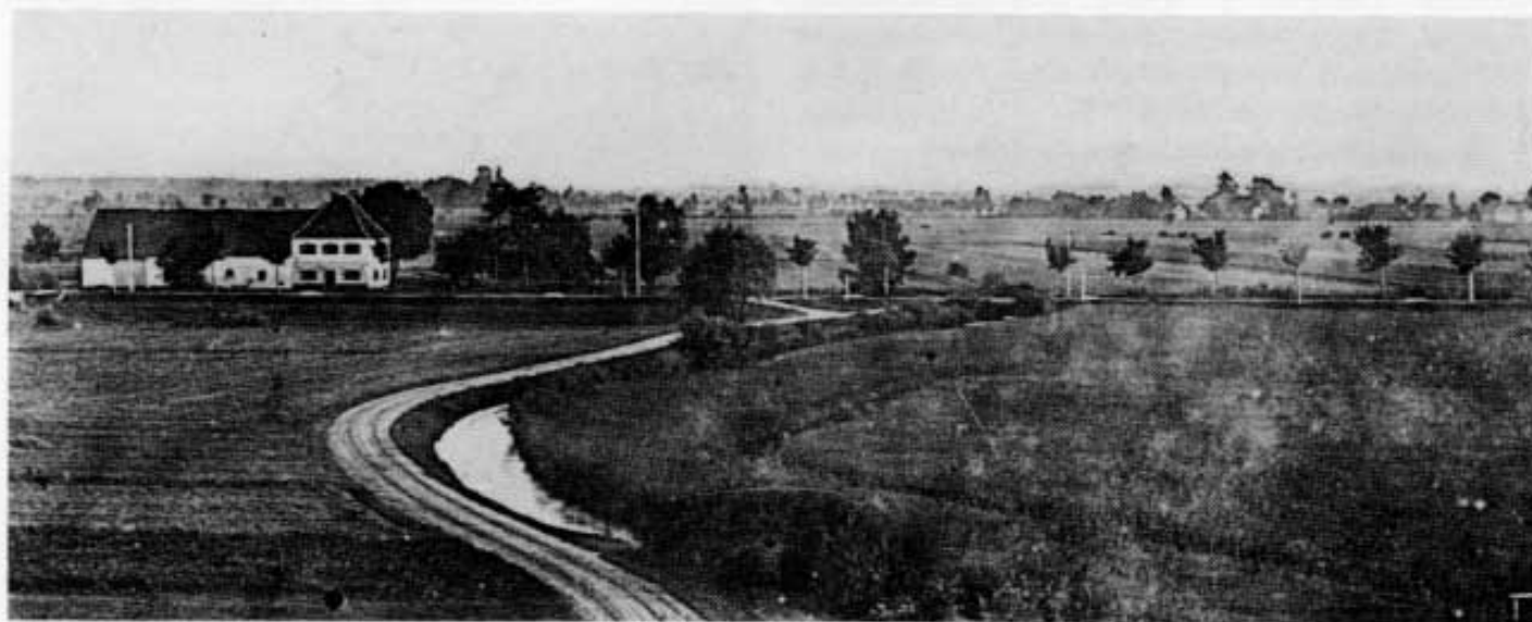
Abb. 1: Eine alte Fotografie zeigt die kleine Moosswaige mit Schleißheimer Straße und Pollnstraße um 1900.
