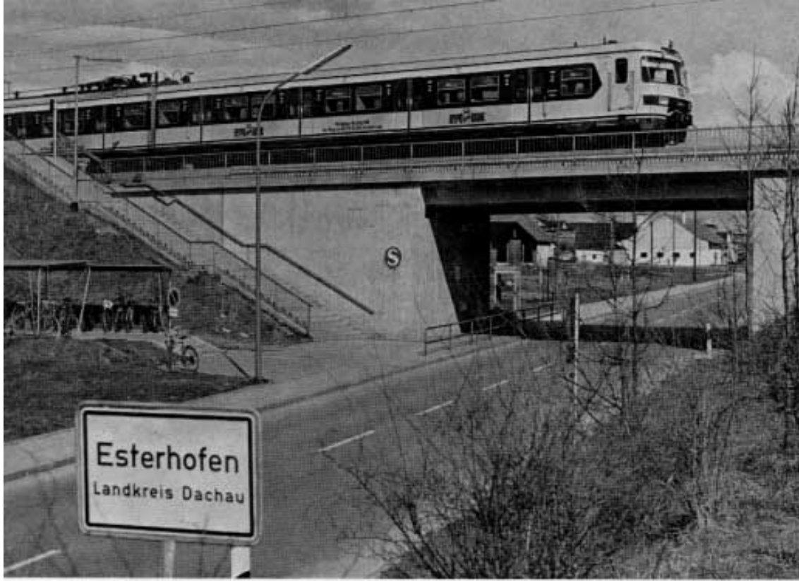
Unterführung Esterhofen mit S-Bahnstation.
