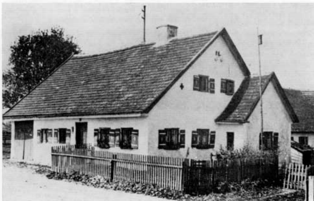
Das Gamperl-Anwesen mit angebautem Austragshäusl in Rettenbach im Jahre 1930.
