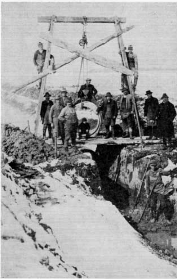
Gemeinsamer Arbeitseinsatz der Rettenbacher Bauern bei der Regulierung des Rettenbaches 1928. Von links nach rechts: oben: Petern, Feierabend; mitte: Görg, Häuslmann, Schlammer Martin, Massinger, Florian Gampenrieder, Schärfti, Lutz, Baur, Vorarbeiter Breitsameter; unten: Westermayr.
