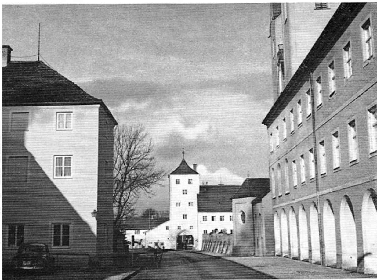
Neue Umgebungsstraße beim Indersdorfer Schneiderturm
