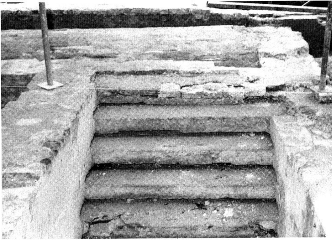
Abb. 4: Ehemaliges nordwestliches Sommerhaus im Dachauer Hofgarten. Kellertreppe mit seitlichen Einschubnuten für Holzstufen. Foto: Gisela Brinkmann, München
