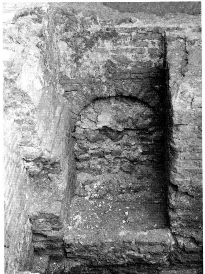
Abb. 5: Ehemaliges nordwestliches Sommerhaus im Dachauer Hofgarten. Zugemauerte Öffnung in der südlichen Außenmauer.
