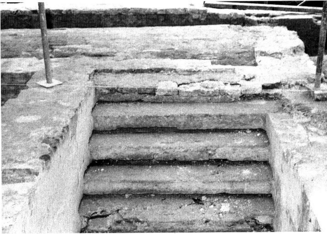
Abb. 4: Ehemaliges nordwestliches Sommerhaus im Dachauer Hofgarten. Kellertreppe mit seitlichen Einschubnuten für Holzstufen.
