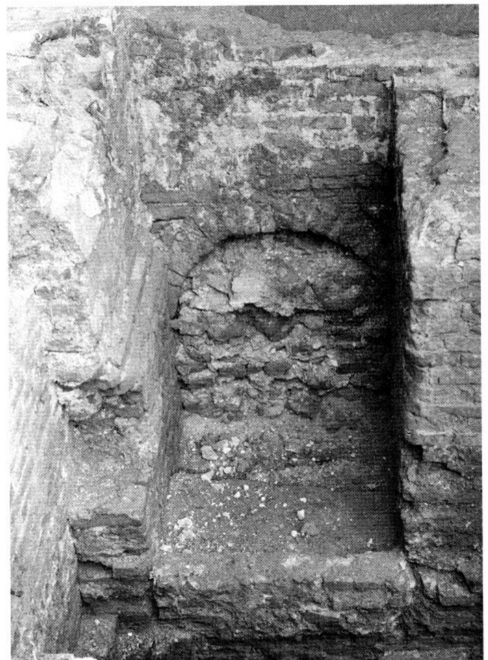
Abb. 5: Ehemaliges nordwestliches Sommerhaus im Dachauer Hofgarten. Zugemauerte Öffnung in der südlichen Außenmauer. Foto: Gisela Brinkmann, München
