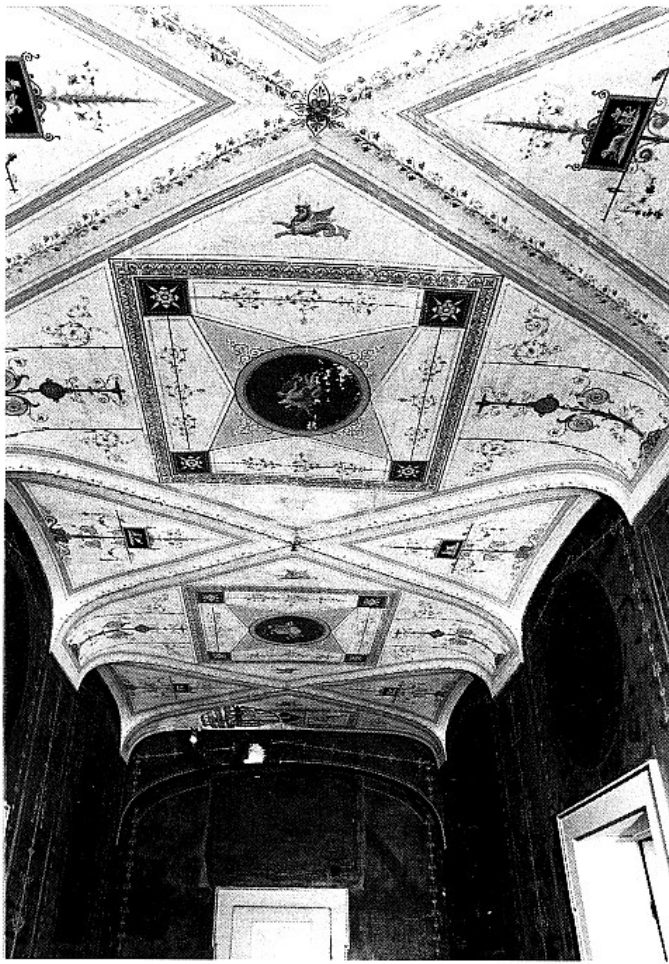
Schloß Weyhern: »Pompejanischer Salon«, Zustand vor der Restaurierung. Foto: Bay. Landesamt für Denkmalpflege
