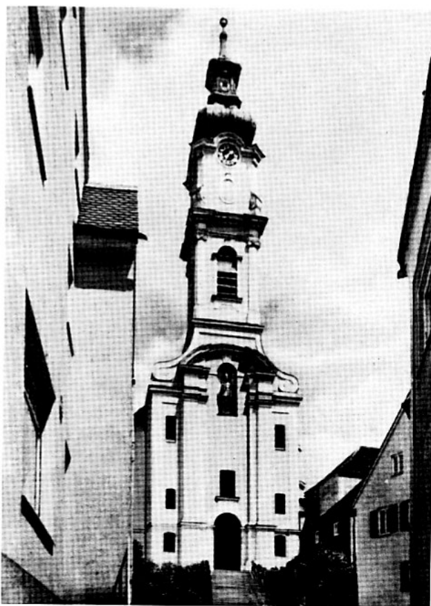
Abb. 5: Turmfassade der ehemaligen Klosterkirche St. Alto.
