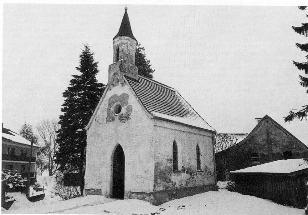
Kapelle St. Maria in Römertsbhofen, Zustand vor der Renovierung.
