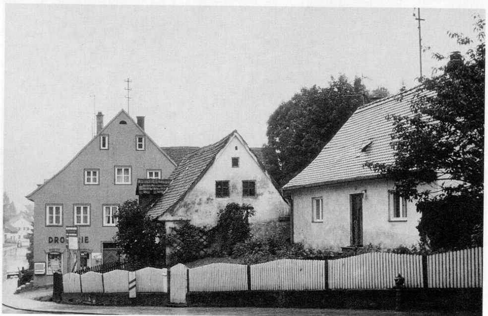
Das Anwesen »Drogerie« in Altomünster, Bahnhofstraße 8, vor dem Umbau zur »Birgitten-Apotheke«, 1976/77.
