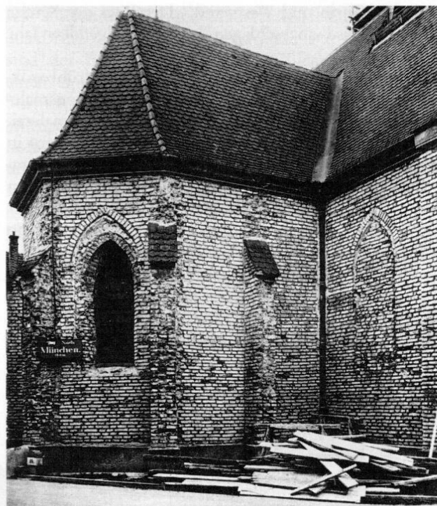
Abb. 3: Nordwestseite 1958. Rechts das vermauerte gotische Fenster des nördlichen Seitenschiffes, links ein Altarraumfenster mit gotischer Grundform, eingestelltem barocken Rundbogenfenster und eingemauertem neugotischen Fensterspitz.
