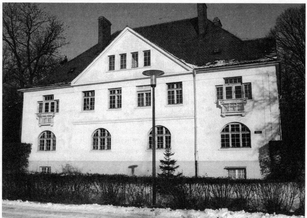
An der heutigen »Straße der KZ-Opfer« zwischen der Wache der VI. Bereitschaftspolizeiabteilung Dachau und der Würm reihen sich die ehemaligen Offiziers- und Beamtenwohnungen der Pulver- und Munitionsfabrik. Sie wurden ab 1919/20 von leitenden und höheren Angestellten der Deutschen Werke AG bezogen.
