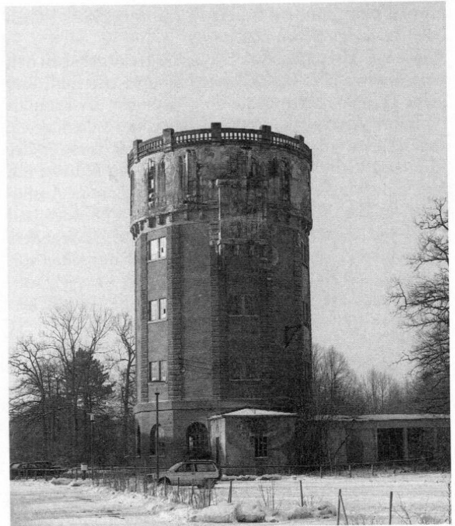
Das Wahrzeichen des ehemaligen Industriegeländes zwischen Amper und Würm: der Wasserturm im Zentrum der vor acht Jahrzehnten errichteten Pulverfabrik Dachau. Bis in die siebziger Jahre hinein diente er der Trinkwasserversorgung auf dem Areal der heutigen bayerischen Bereitschaftspolizei.
