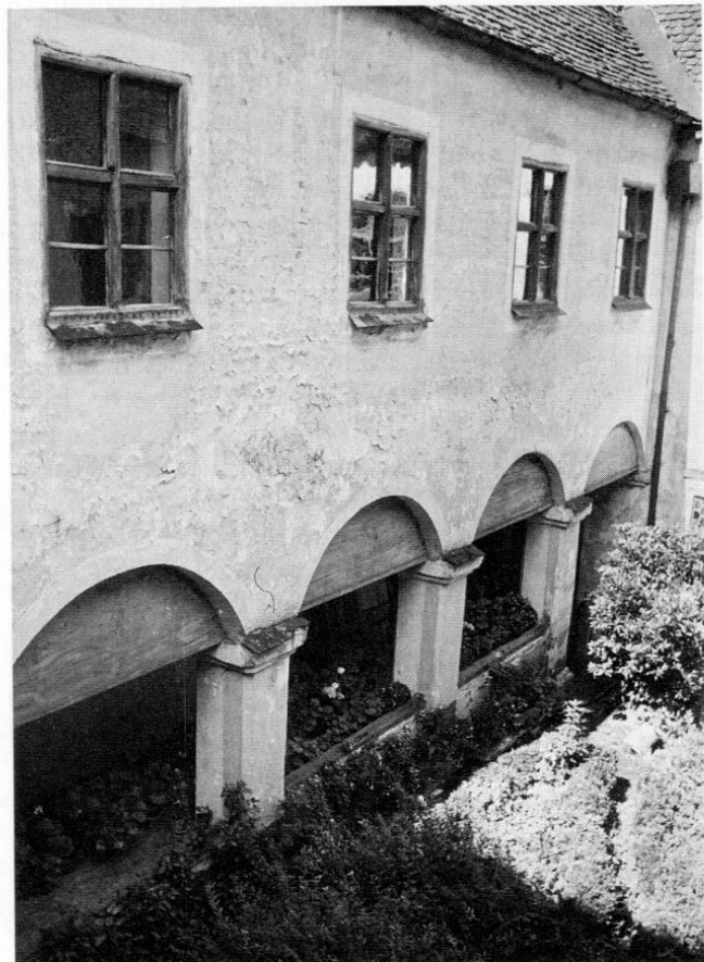
Blick in den ehemaligen Kreuzgang des Frauenklosters vor der Renovierung.
