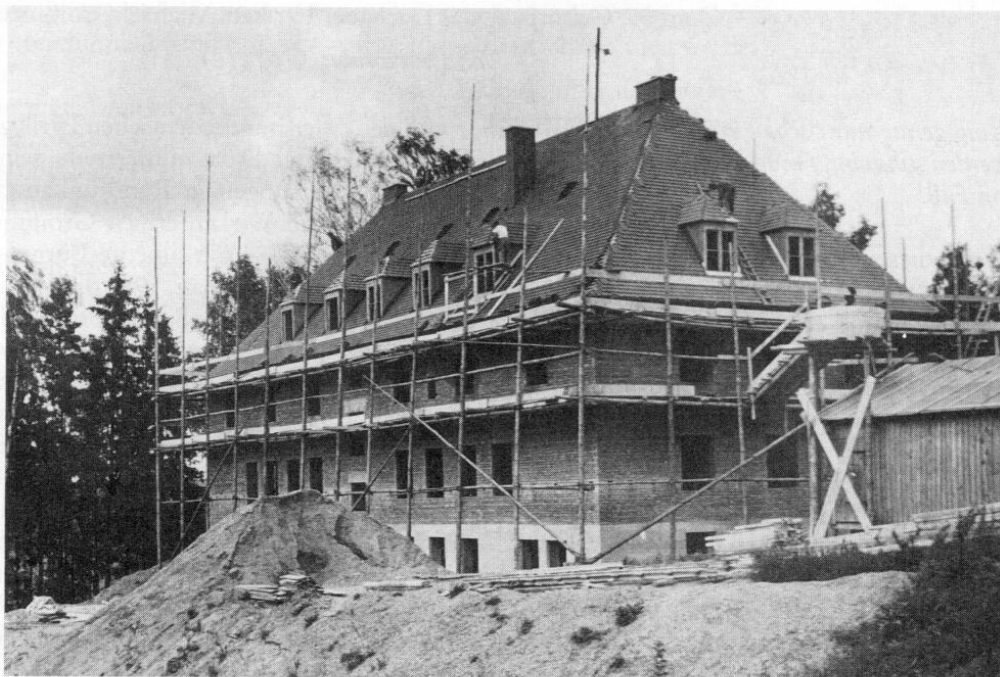
Rohbau des Oberen Hauses der Landvolkshochschule auf dem Petersberg.
