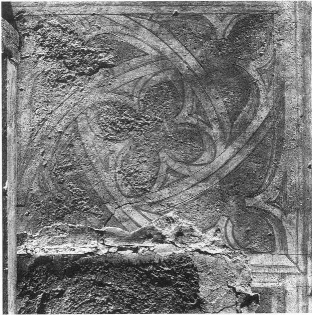
Abb. 7: Freising, Obere Domberggasse 5, Kämpferfeld mit sphärischer Viereckrahmung des Vierpasses mit Vorritzungen vor der Konservierung und Restaurierung. Foto: Bayer. Landesamt f. Denkmalpflege, Lantz 1991
