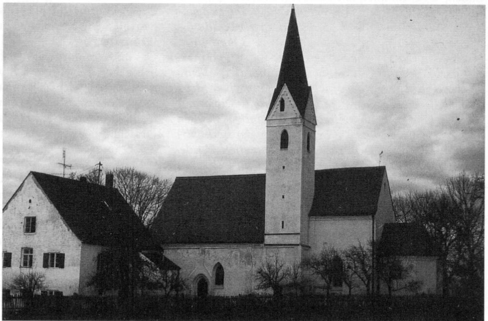
Abb. 1: Wallfahrtskirche Maria Rast von Süden mit dem ehemaligen Benefiziatenhaus, 1973.
