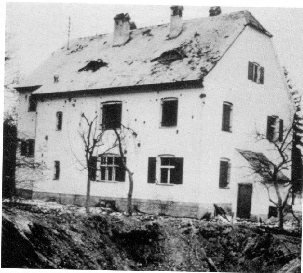
Bombenkrater im Garten des katholischen Pfarramts St. Peter und Paul in der Pfarrstraße. Die Löcher in der Wand rühren von Granatsplittern her.
