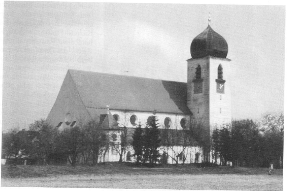
Äußeres der Pfarrkirche Leiden Christi, München- Obermenzing, von Süd- westen. (Foto: Hans Jürgen Stein, Kettenschwang)
