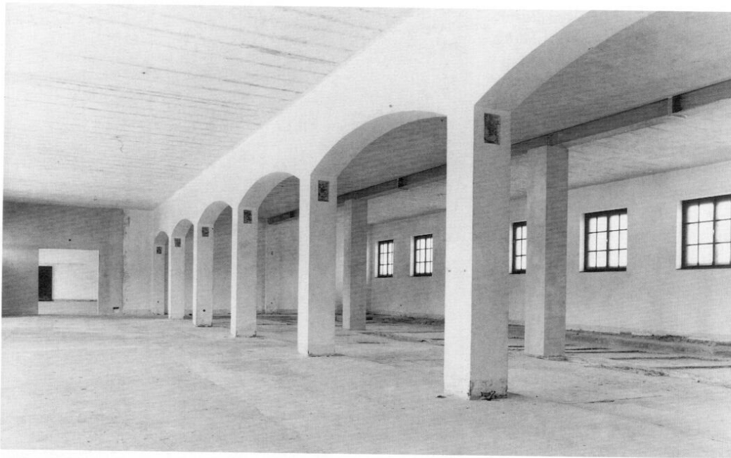
Im Häftlingsbad wurde die im Boden vertiefte Duschwanne (rechts unter den Fenstern) wieder freigelegt. Unter den Bögen sind die ebenfalls freigelegten Befestigungspunkte der Balken für das Pfahlhängen zu erkennen. Die Suche nach der historischen Raumnutzung war ein konzeptueller Schwerpunkt bei der Neugestaltung.
