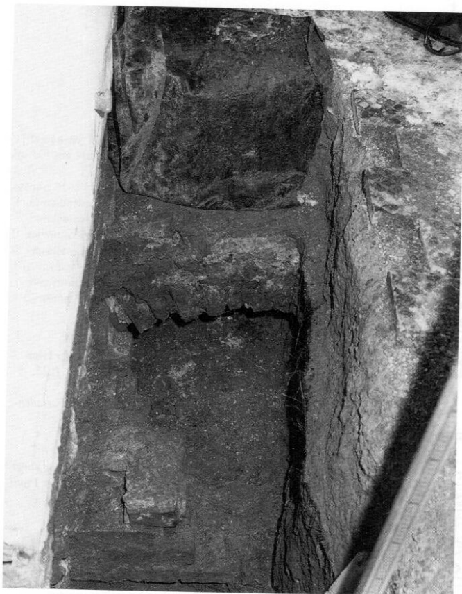
8 Altomünster, Sondage vor der Westfassade 2003. Fundament eines (spätgotischen?) Anbaus an den Westturm des Vorgängerbaus, darüber ein Entlastungsbogen, darunter Kanalgewölbe, von Norden.
