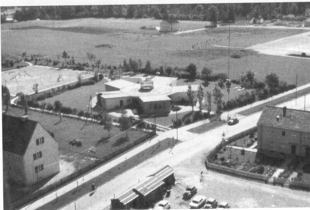
Der Sternkindergarten vom Kirchturm St. Bernhard, ca. 1960
