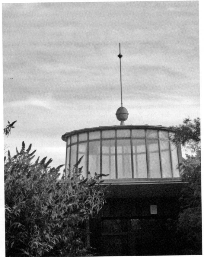
Lichtkuppel des Sternkindergartens, 2005
