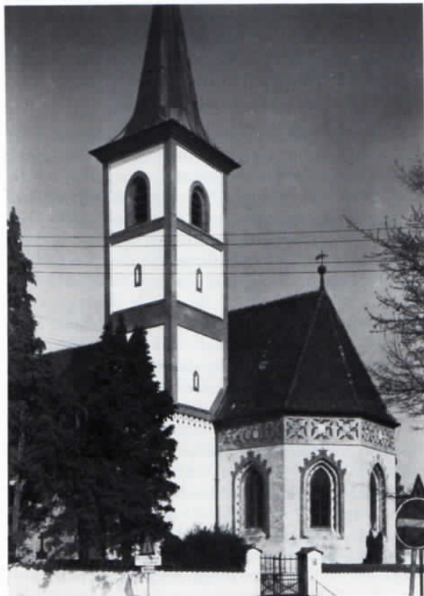
Abb. 3: Der Turm von St. Wolfgang, der seit der Renovierung 1979 wieder in der Fassung des frühen 16. Jahrhunderts erstrahlt.
