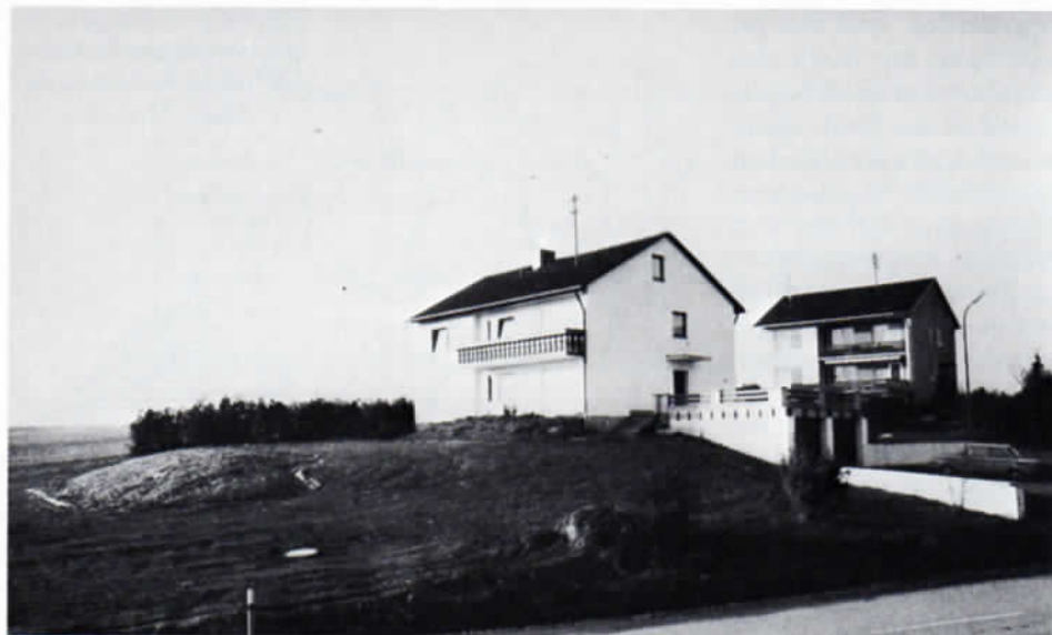
Abb. 7: Stumme, aufdringliche Ungetüme in exponierter Lage: Wohnhäuser in Riedenzhofen.
