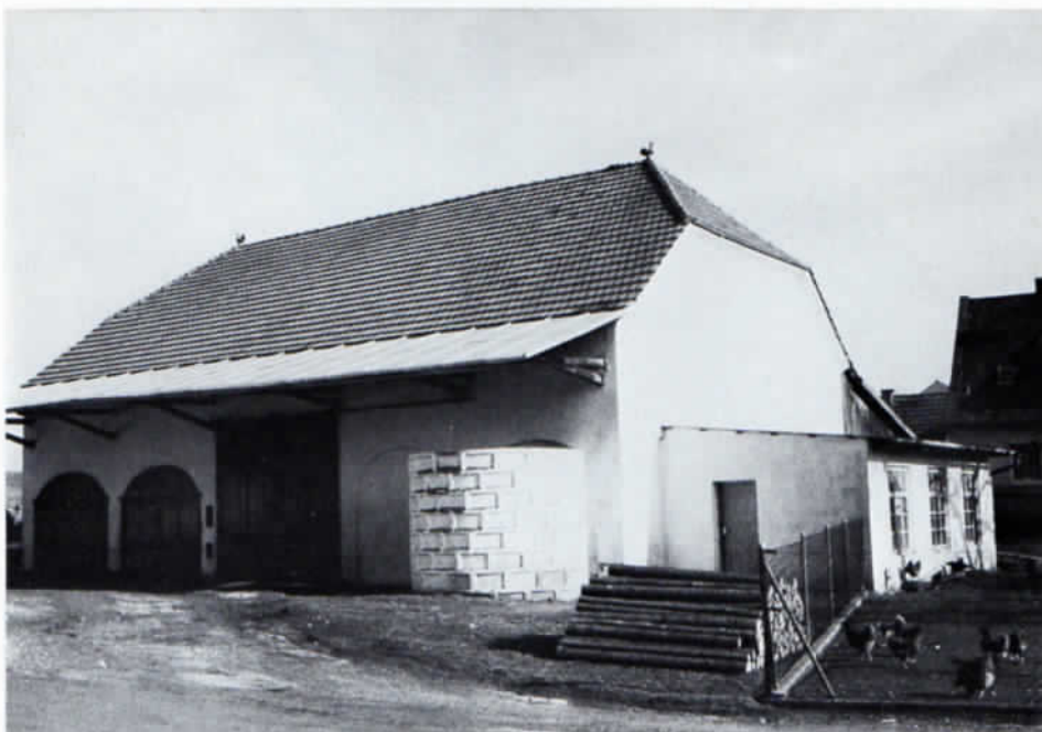
Abb. 5: Dieser Stadel mit Halbwalmdach, Teil eines Dreiseithofes in Kammerberg, ist, wie die übrigen Gebäude des Hofes, in gutem Bauzustand. Eine vorbildliche Sanierung erhielt diesen alten Baubestand.
