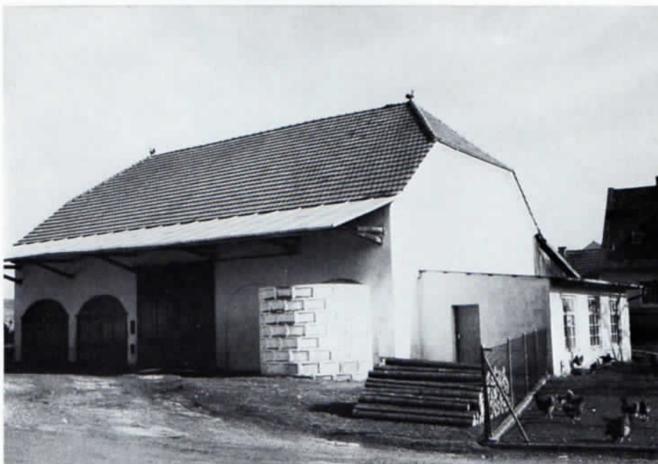
Abb. 5: Dieser Stadel mit Halbwalmdach, Teil eines Dreiseithofes in Kammerberg, ist, wie die übrigen Gebäude des Hofes, in gutem Bauzustand. Eine vorbildliche Sanierung erhielt diesen alten Baubestand.
