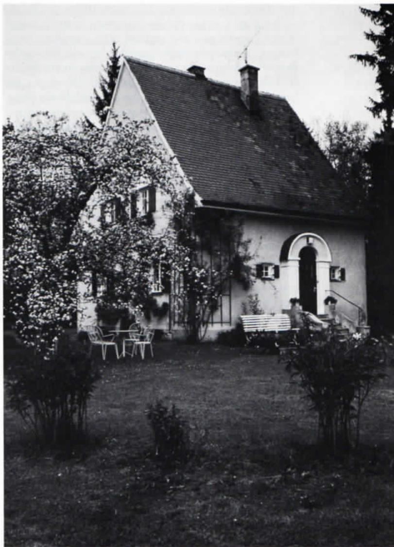
Das »Thiemann-Haus« in Dachau, Hermann-Stockmann-Straße 20.
