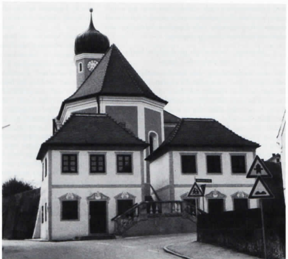
Pfarrkirche in Haag an der Amper mit Bruderschaftshäuschen.
