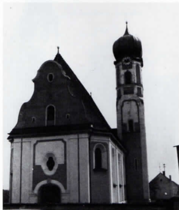
Am Ende des Historismus im Bauwesen des 19. Jahrhunderts steht die neubarocke Filialkirche in Oberbaindlfing, 1908/09 nach den Plänen des Münchener Architekten Johann Schott erbaut.
