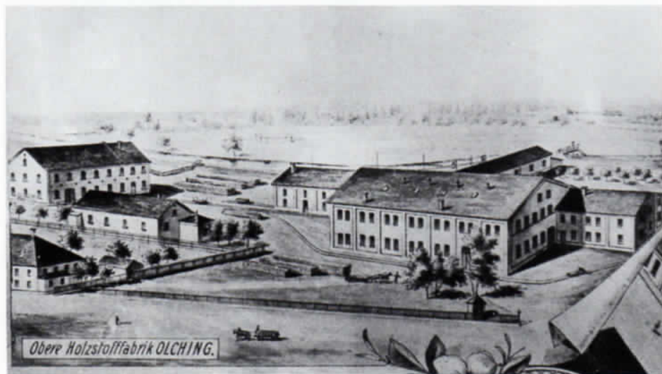
Ein Ausschnitt mit dem »Oberen Werk« aus der wohl ältesten Darstellung aller um die Jahrhundertwende vorhandenen Werke der MD-Papierfabriken aus der Vogelperspektive.
