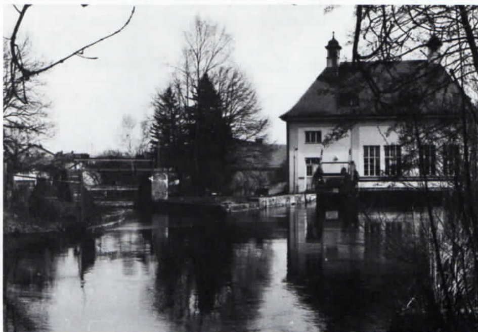
Heutiges Aussehen des vor 100 Jahren erbauten Kraftwerkes in Olching.
