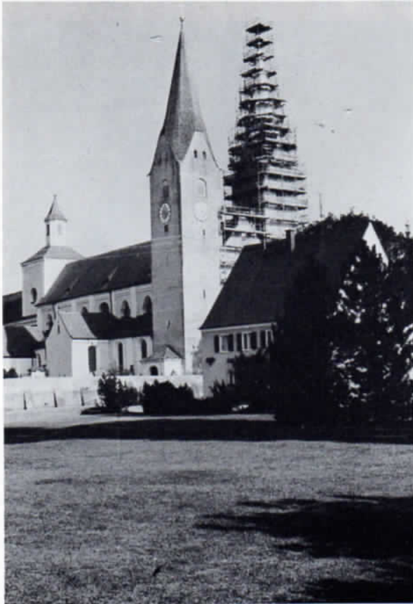
Pfarrkirche Kloster Indersdorf. Südturm und Westfassade sind eingerüstet, die Außenrestaurierung der Kirche – ohne Türme und Westwerk – ist abgeschlossen.
