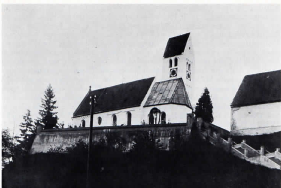
Die alte Pfarrkirche St. Georg in Hebertshausen im Jahre 1926. Die Friedhofsmauer wurde 1921 errichtet.
