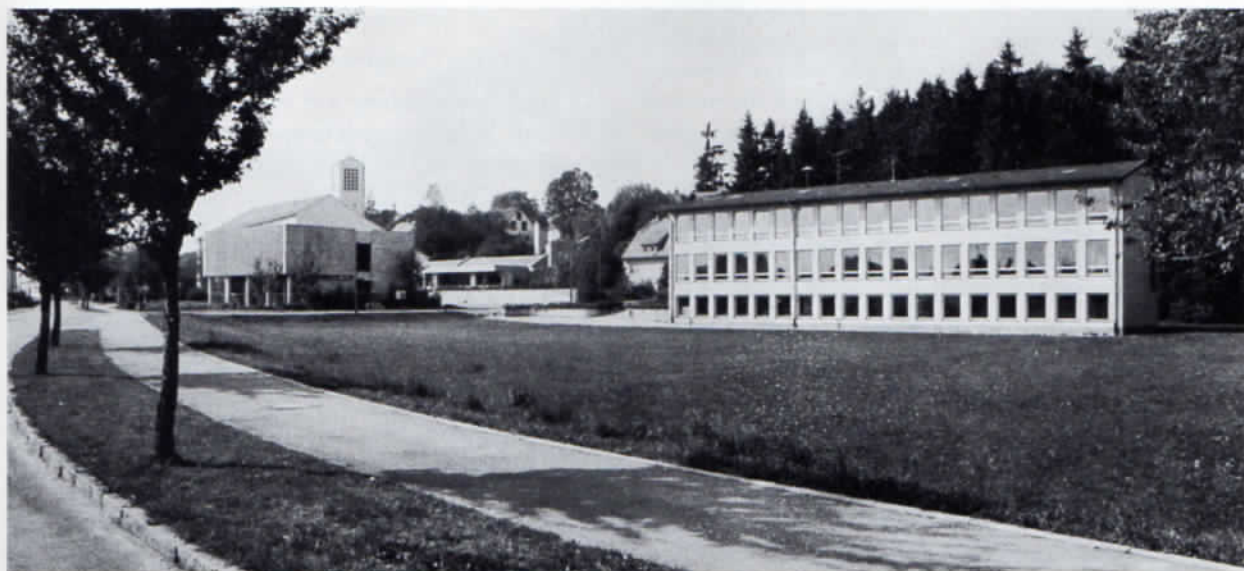
Schulgebäude von Hebertshausen vor Erstellung des Schulpavillons im September 1973. Links Rathaus, dahinter neue Pfarrkirche.
