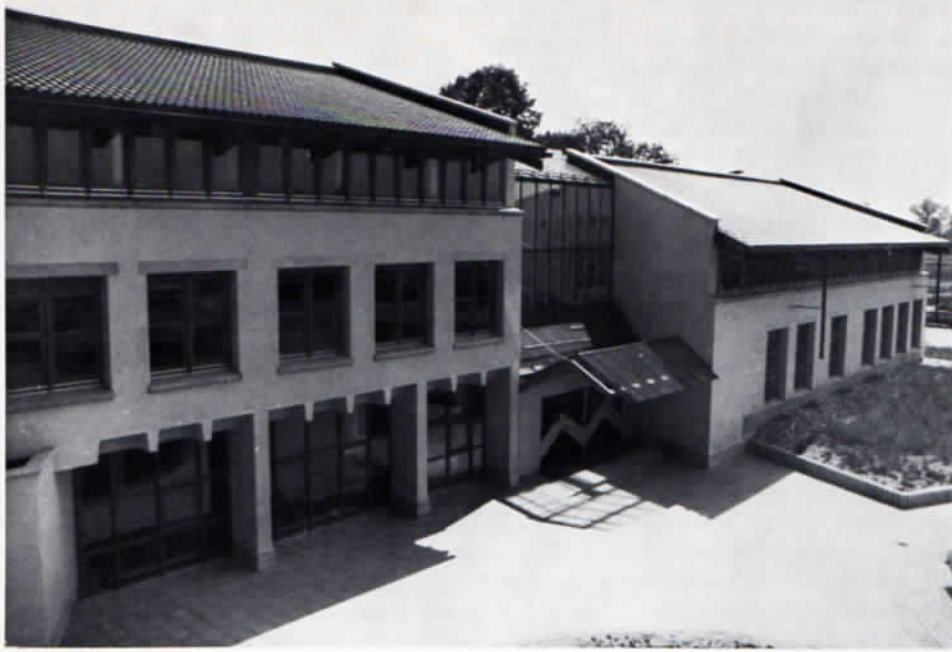
Der Schulhauserweiterungsbau von Hebertshausen im Juni 1982. Foto: Niels Jörgensen, Dachau
