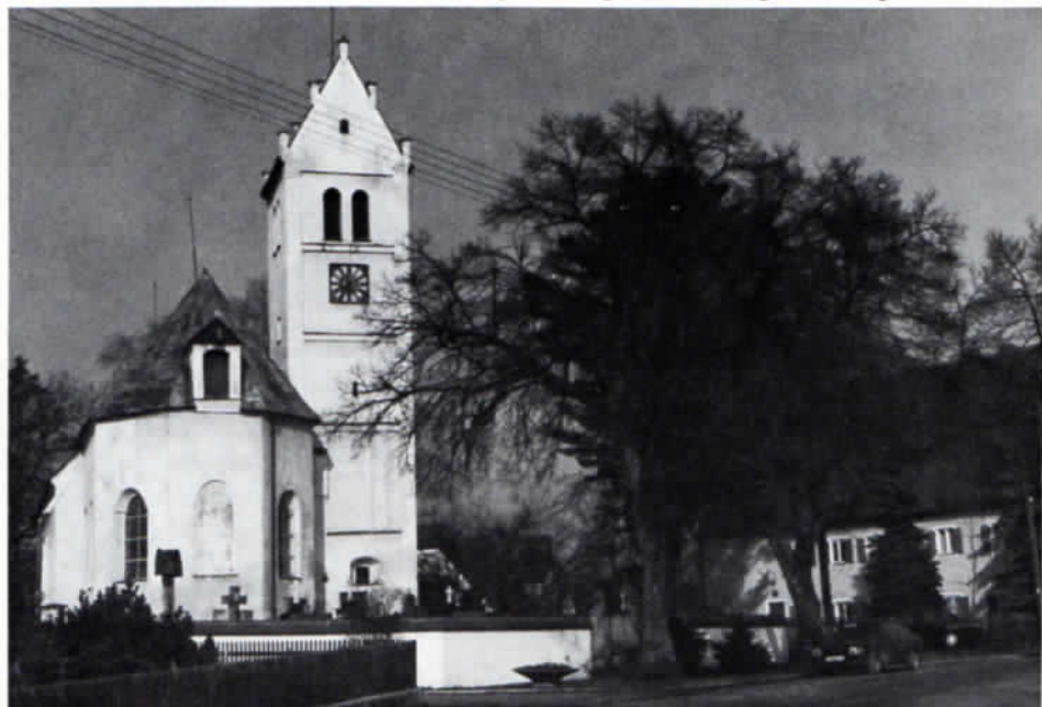
Die zwischen 1440 und 1500 erbaute Pfarrkirche in Dünzelbach. Rechts, leicht verdeckt das Gräfl. v. Törring'sche Forstant.
