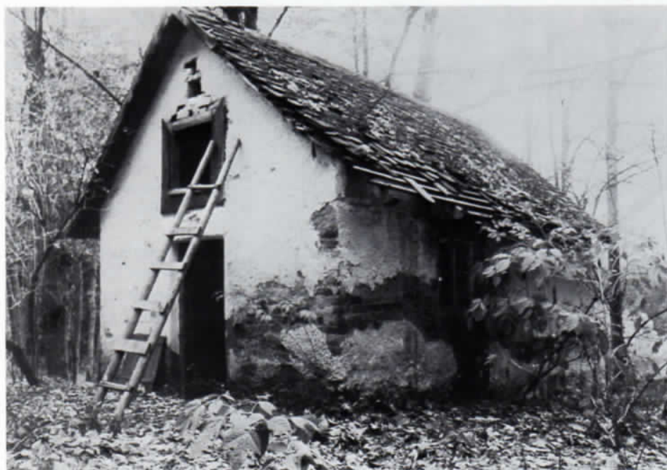
Oberberghausen, ehemaliges Waldhüterhaus.
