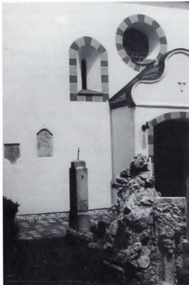
Das von Pfarrer i. R. Anton Bauer freigelegte romanische Fenster der St.-Martins-Kirche in Moosach im heutigen Zustand.
