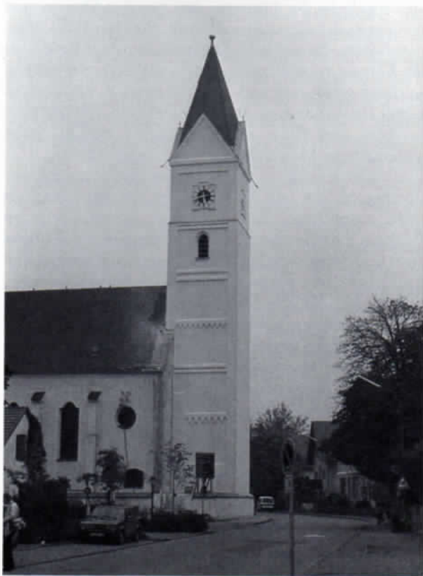
Wallfahrtskirche St. Wilgefortis in Neufahrn, Lkr. Freising.
