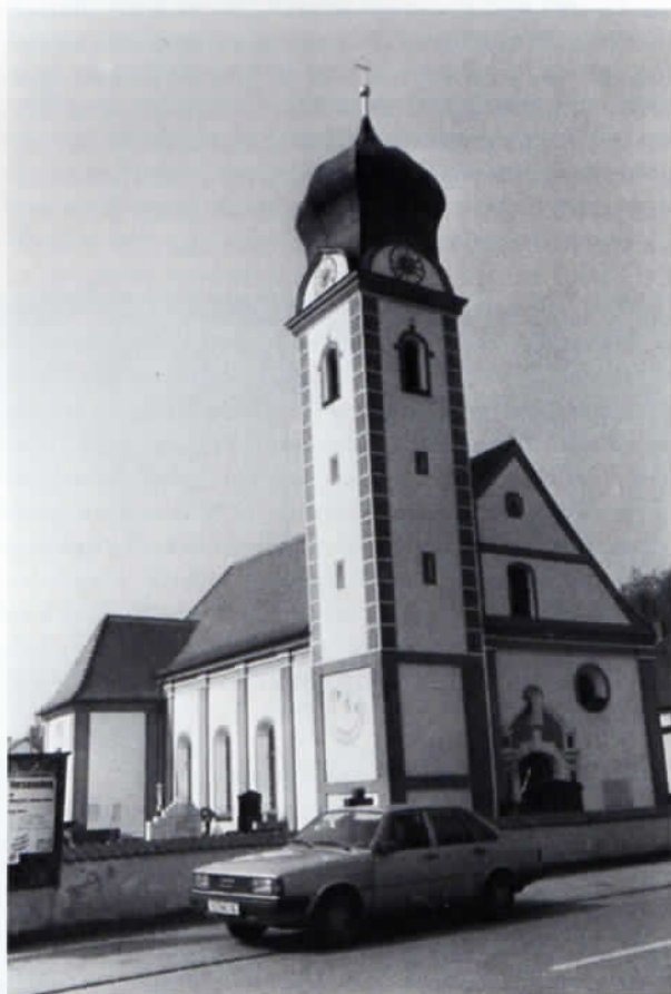
Die barocke Langenbacher Pfarrkirche wurde 1737 erbaut.
