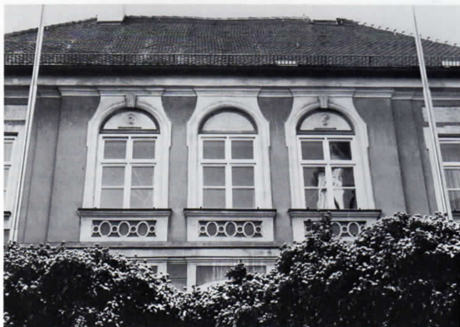
Das 1790 als kurfürstliches Kastenamt erbaute alte Dachauer Finanzamtsgebäude. In den Bögen über den beiden äußeren Fenstern sind zwei stark übermalte Portaitreliefs schwach zu erkennen. Zustand vor der Renovierung. Foto: Dr. Peter Dörner
