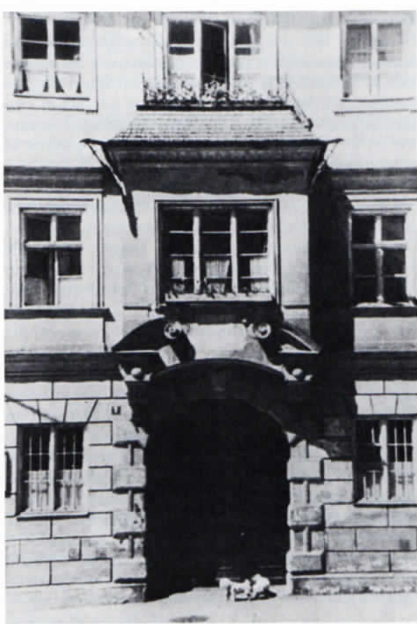
Das einstige Klostrerrichterhaus in Fürstenfeldbruck. Zustand von etwa 1960.
