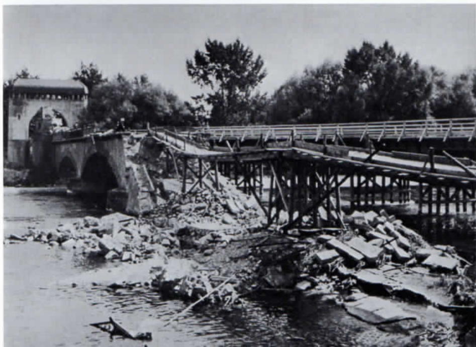
Die im Jahre 1945 zerstörte Freisinger Isarbrücke von 1894.
