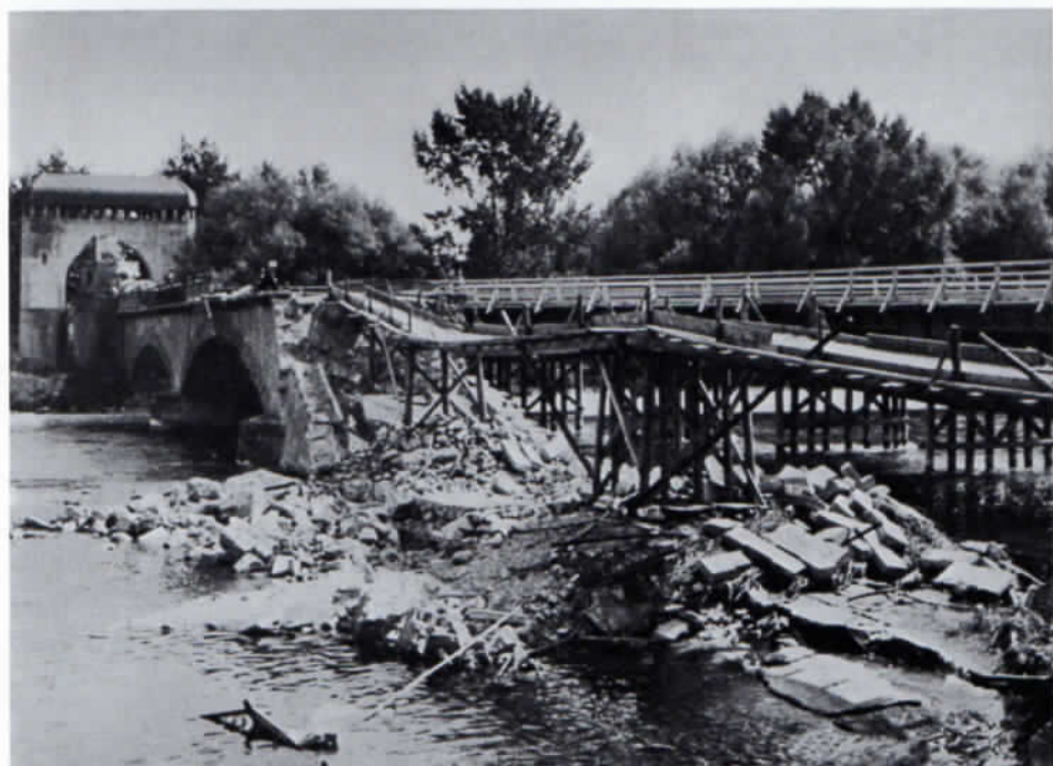
Die im Jahre 1945 zerstörte Freisinger Isarbrücke von 1894.
