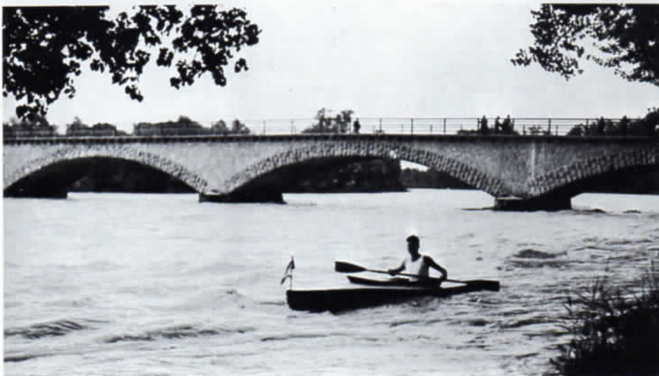
Die 1948 erbaute Freisinger Isarbrücke.
