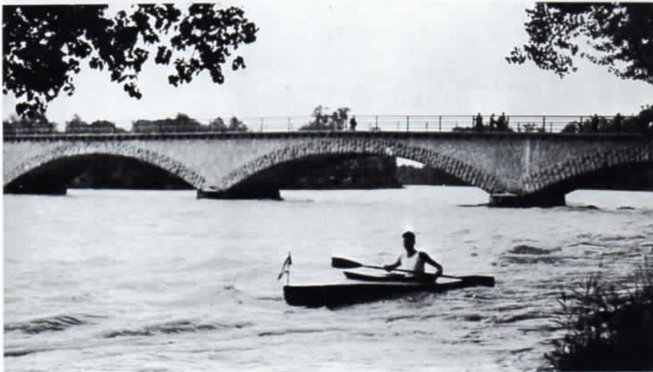
Die 1948 erbaute Freisinger Isarbrücke.
