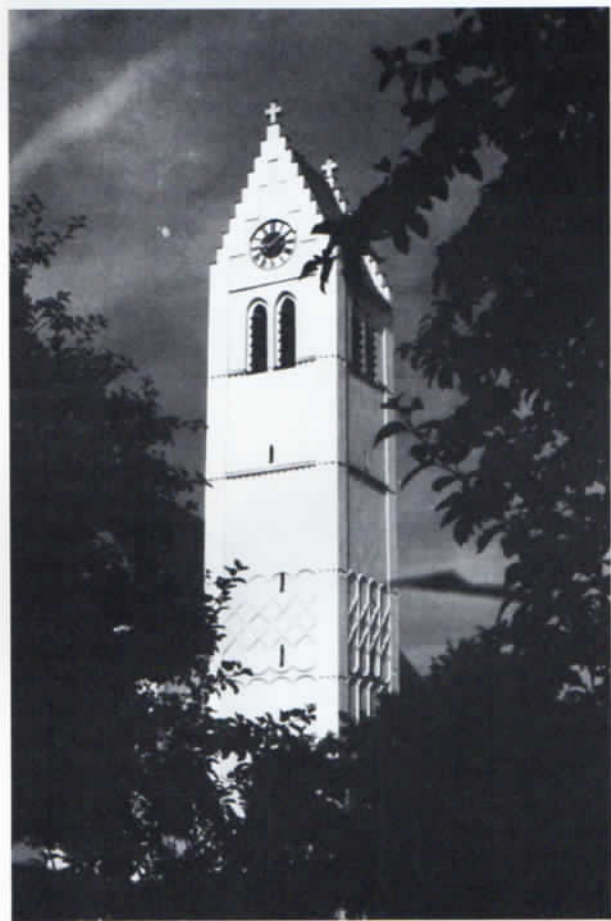
Ampemoching, Lkr. Dachau, Bau aus dem späten 15. Jahrhundert. Schöner, mit Stabwerk und Deutschem Band gegliederter Turm.
