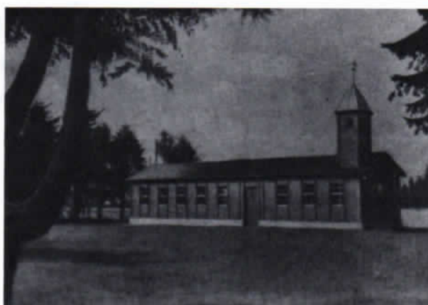
Notkirche St. Raphael in Hartmannshofen, eine ehemalige Baracke aus dem Kriegsgefangenenlager Puchheim. Repro: Georg Mooseder, München
