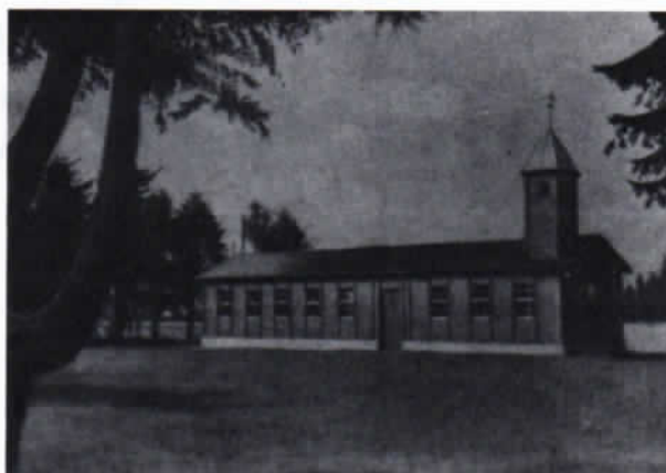
Notkirche St. Raphael in Hartmannshofen, eine ehemalige Baracke aus dem Kriegsgefangenenlager Puchheim. Repr: Georg Mooseder, München
